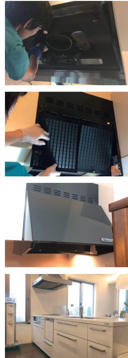
細かいパーツまで分解洗浄。内部のベタベタ汚れを取り除いて、換気効率もアップ。
