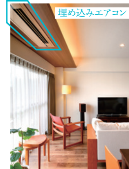
リビングの天井に埋め込み式のエアコンを設置。天井の下がり部分を利用して間接照明に。
