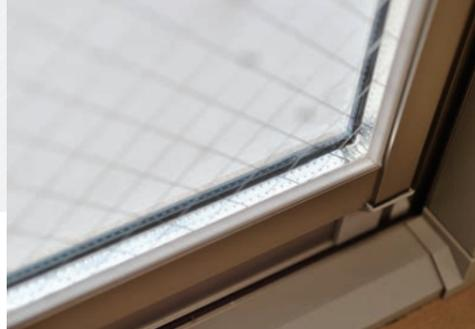
内側が網入りガラス、外は透明ガラスの2枚ガラスになっています。2枚のガラスの間にはアルゴンガスまたは乾燥空気が入っているため高い断熱効果を発揮します。
